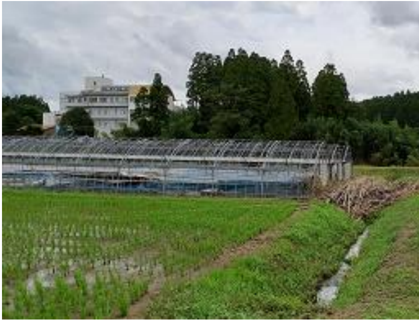
環境省撮影 農業ハウス損壊状況 (令和3年7月15日時点)
