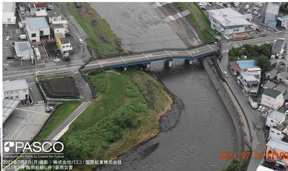
(株) パスコ撮影 黄瀬川大橋 損壊状況 (令和3年7月5日時点)
