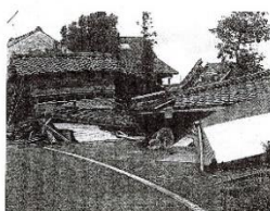
家屋被害の状況(柏崎市内) (提供:県ホームページより)
