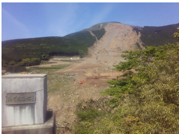
大規模地すべりによる 阿蘇大橋の崩落（南阿蘇村）
